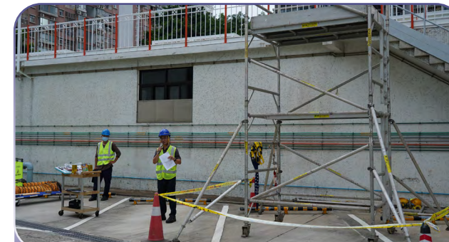
高空作業演習 Exercício de trabalho em altura Working-at-heights drill
